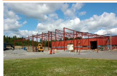
EdmoLift Ausbau Juli 2010
