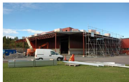
EdmoLift Ausbau September 2010
